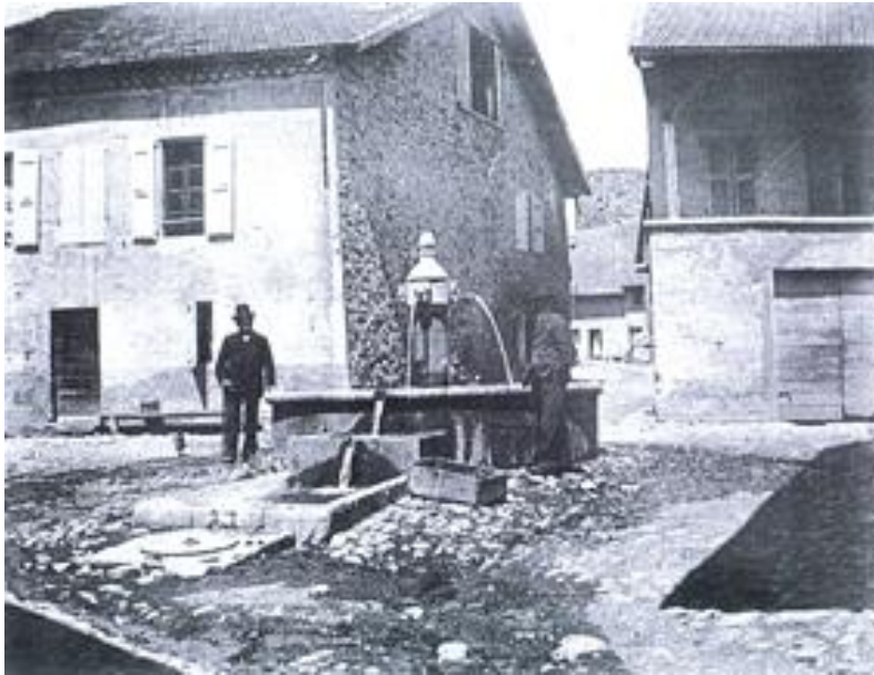
La Bâtie-Neuve : place et fontaine dans la rue principale
