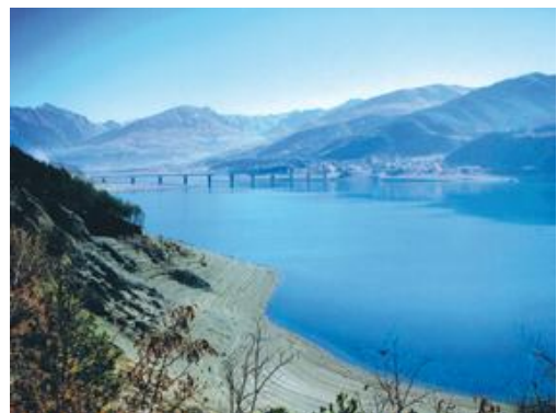
Serre-Ponçon Le pont de Savines
